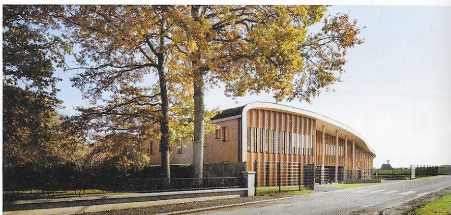
▲ Murs, façades rideaux bois et couverture végétalisée assurent un traitement optimal des ponts thermiques de l'enveloppe du collège.
