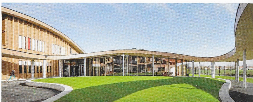
▲ Les courbures et ondulations de la charpente sont réalisées par un platelage bois (chevrons et voliges sur pannes et arbalétriers de la charpente).
