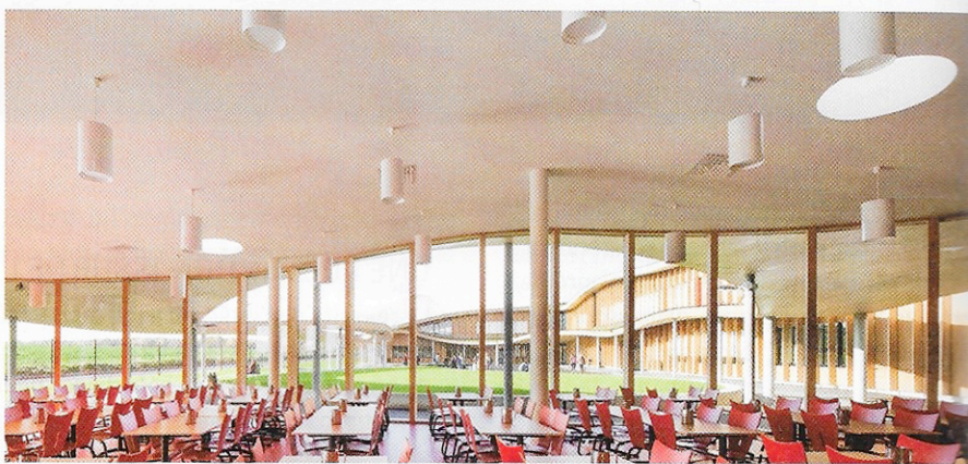
▲ Les menuiseries extérieures sont de deux types : en acier pour les portes et mixtes bois/aluminium pour les grandes baies vitrées qui apportent un maximum de lumière naturelle.
